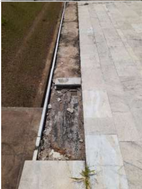
Fotografia 28: Vista da borda da laje, onde foi removido o mármore. Observamos as placas de mármore aplicados com “insert” metálico;
