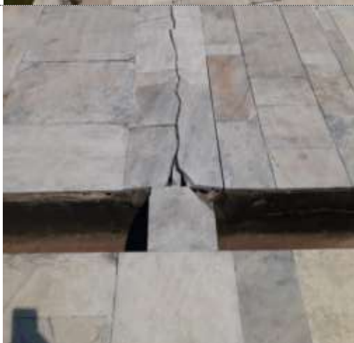
Fotografia 26: Vista da junta de movimentação do piso, onde observamos que a peça fissurou no meio da pedra;
