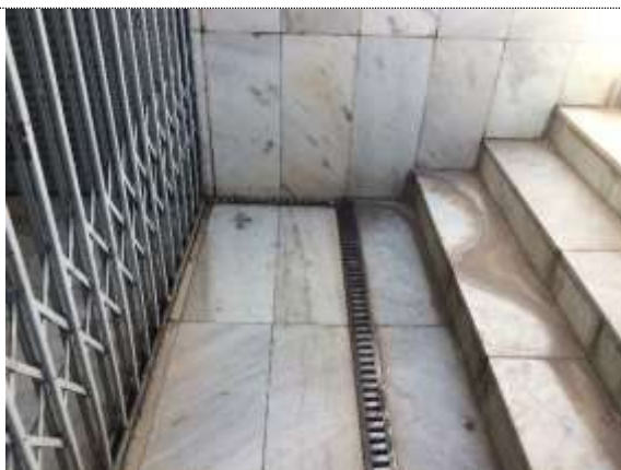
Fotografia 18: Vista da grelha do ralo linear da escada de acesso aos plenários ;
