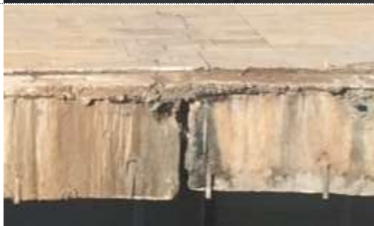
Fotografia 31: Vista da lateral da laje, onde destacamos a presença dos inserts de apoio das placas da platibanda;
